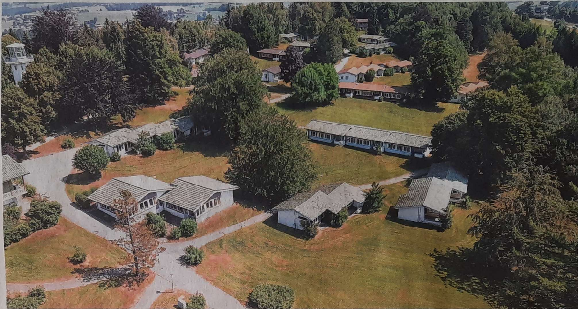
Noch stehen die kleinen Bungalows auf dem Nadenberg. Sie sollen aber einem Hotel und einer Wohnbebauung weichen. Foto: Olaf Winkler (Archiv)
